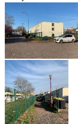
Ferme Saint Ladre, rue de la ferme St Ladre
