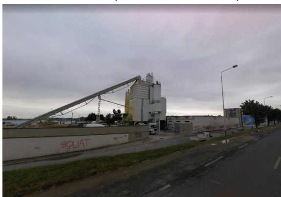
Création de nouvelles cellules commerciales sur l'ancien site Silvex :
