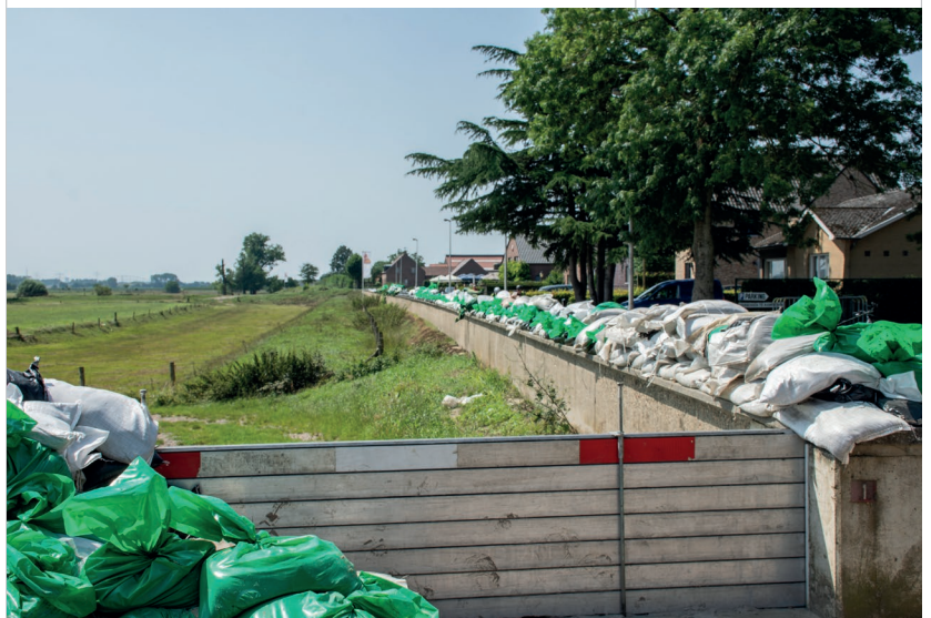
CLÔTURE ET SACS DE SABLE SUR LA DIGUE DE HEPPENEERT EN BELGIQUE POUR EMPÊCHER LES INONDATIONS DE LA RIVIÈRE MAAS - photo Adobe Stock
