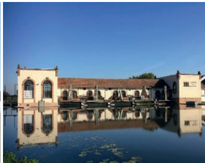
USINE HYDROÉLECTRIQUE, ESCHAU
