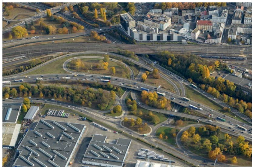
ÉCHANGEUR DE CRONENBOURG EN 2018 : avant l'ouverture de l'autoroute A355. Cette dernière a permis un report massif du trafic de poids-lourds, ce qui a eu pour effet d'améliorer la sécurité, les conditions de trafic et donc l'attractivité de la M35.
