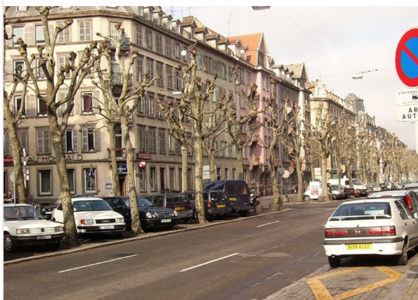
BOULEVARD DE LYON À STRASBOURG EN 2006 : la 2x3 voies a laissé place à la ligne de Bus à Haut Niveau de Service G et à une voie cyclable en site propre.
