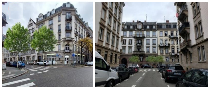
La végétation, élément de composition : effet de « porte », localisation en fond de perspective
