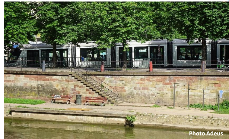
Quai bas du fossé du faux rempart, accessible uniquement par des escaliers
