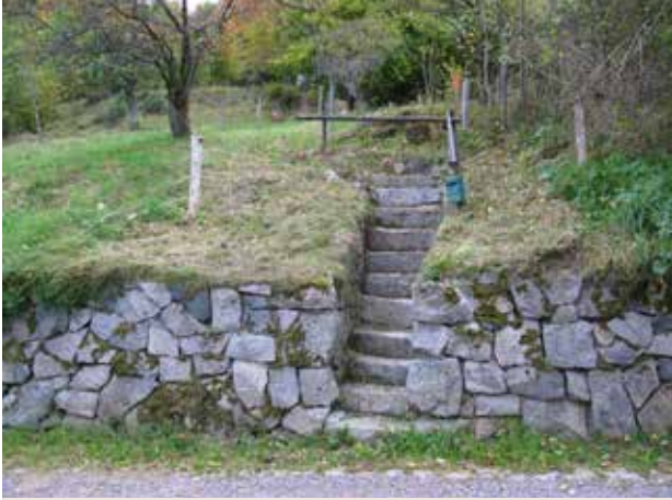
ESCALIERS EN PIERRE DONNANT ACCÈS AU VERGER ET HABITATION
