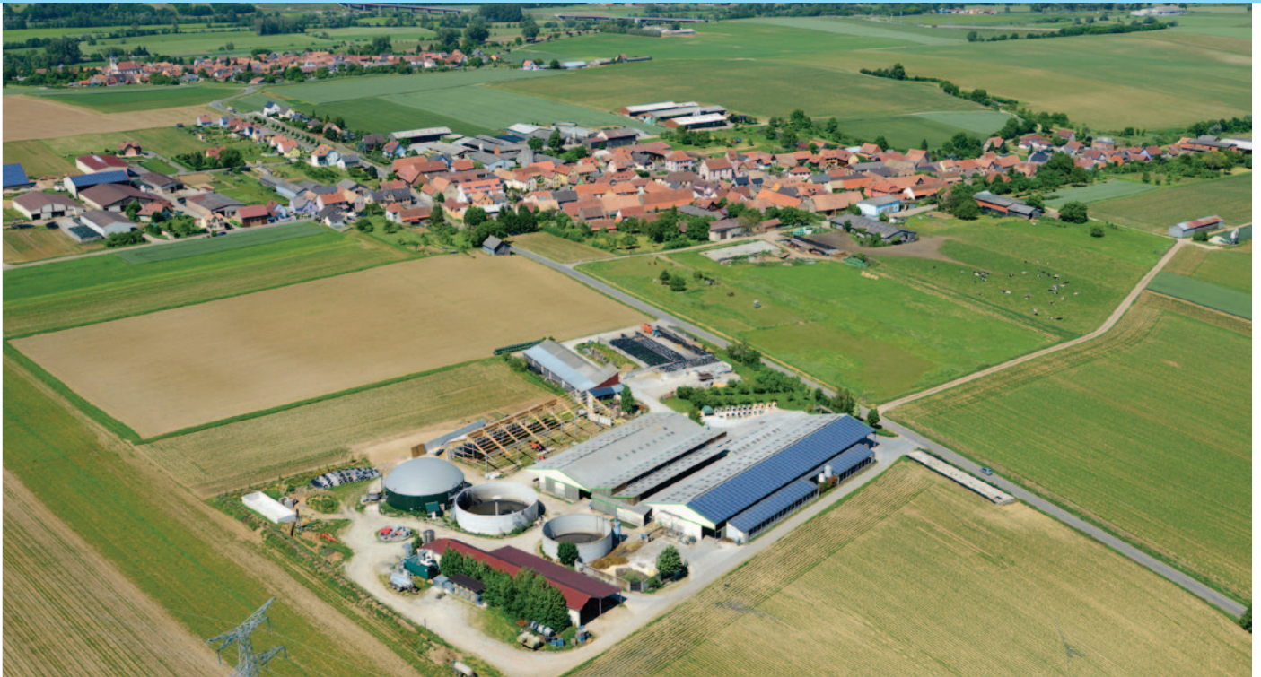
Unité de méthanisation et panneaux photovoltaïques sur toiture, Littenheim
