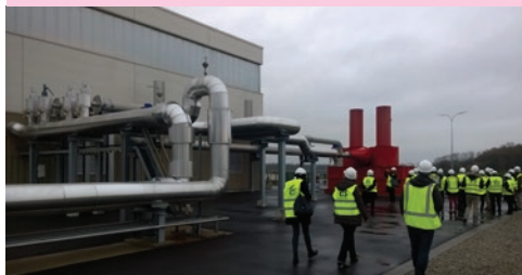
VISITE DE LA CENTRALE GÉOTHERMIQUE À RITTERSHOFFEN (PILOTÉE PAR EDF, DÉLÉGATION RÉGIONALE GRAND EST), DANS LE CADRE DE LA 38E RENCONTRE DES AGENCES D'URBANISME À STRASBOURG, NOV. 2017
