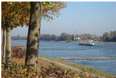
Aménagement au niveau du delta de la Sauer
