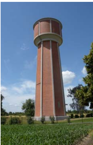
Les châteaux d'eau manifestent la présence de l'eau
