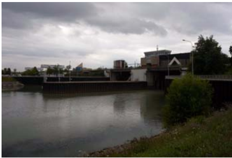
Le barrage de Gamsheim
