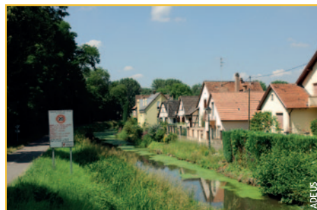
Valoriser les abords du canal
