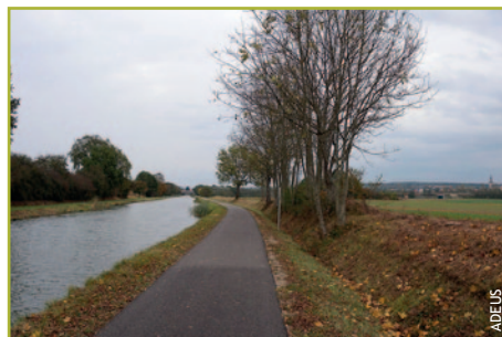
Le canal, un axe structurant à renforcer
