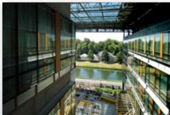
Construction du nouveau bâtiment général du Conseil de l'Europe.
