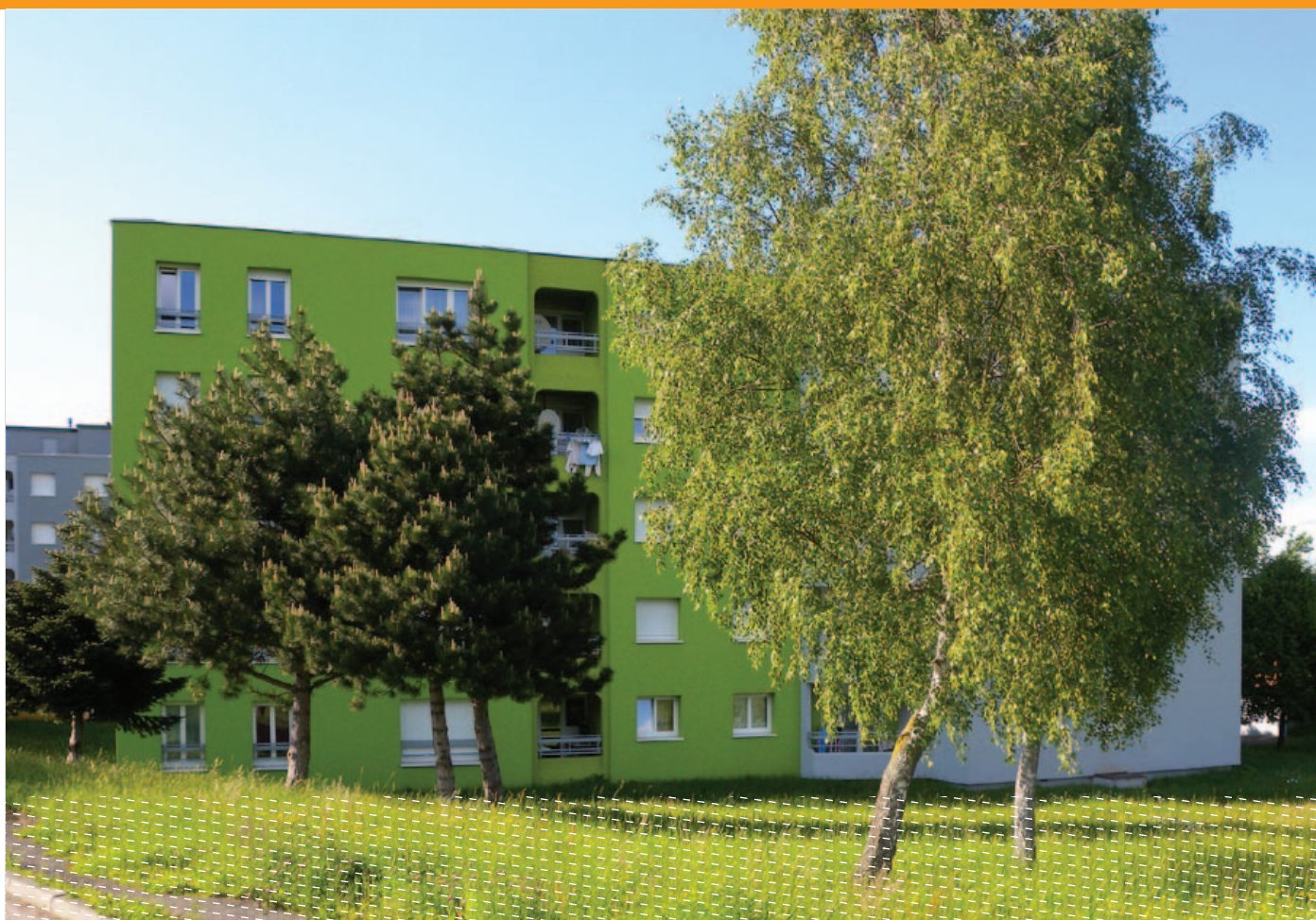
LOGEMENTS LOCATIFS SOCIAUX À SAVERNE
