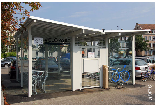
Véloparc d'une station tramway
