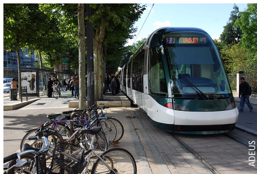
Station tramway équipée d'arceaux.
