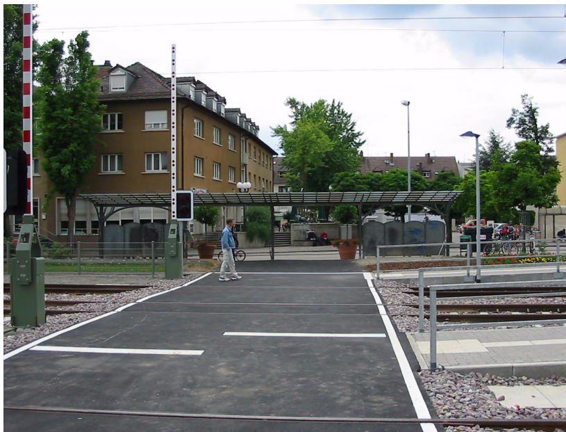
PHOTO N°6 : Passage à niveau permettant une liaison piétonne urbaine
