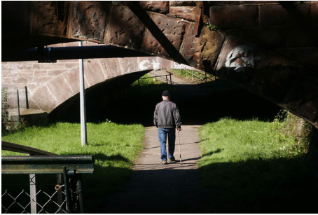
PHOTO N°4 : Le passage voûté sous les voies ferrées
