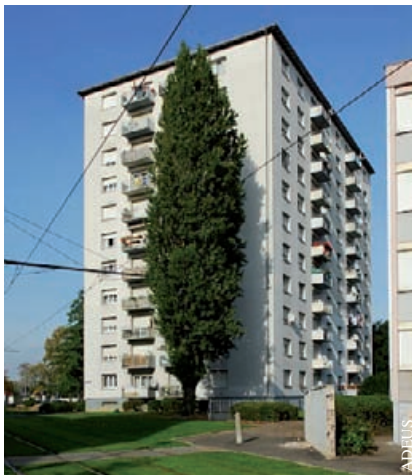
Neuhof – Tour de logements sociaux
