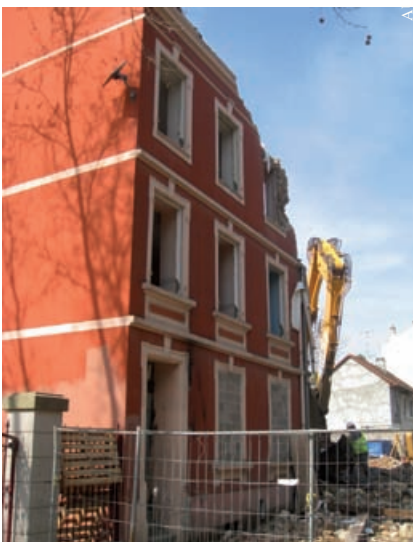
Wolf-Wagner-Vauban-Neppert– Démolition d'immeuble rue des Chaudronniers
