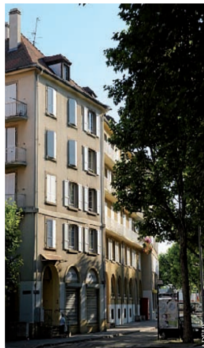
Port du Rhin - Immeuble de logement social
