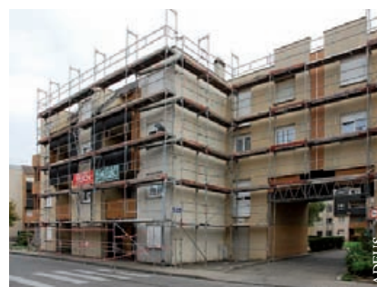
Koenigshoffen – Réhabilitation de logements sociaux rue de la Charmille
