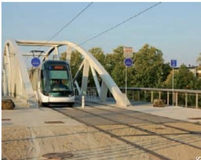
Montagne-Verte – Nouvelle passerelle piétons-tramway
