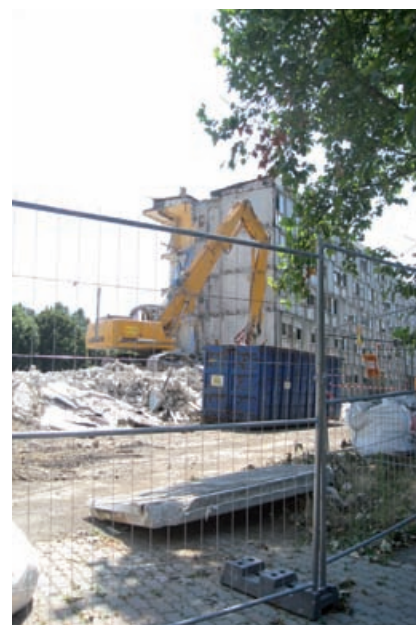
Bourzwiller – Démolition des 420
