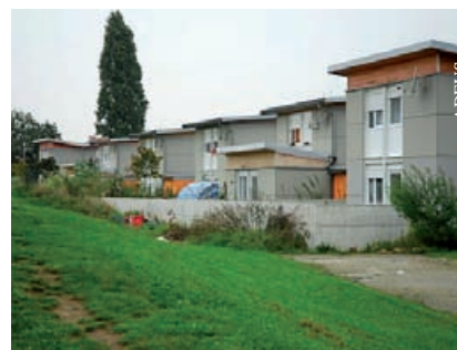
Neuhof – Nouveaux pavillons Cité des Aviateurs
