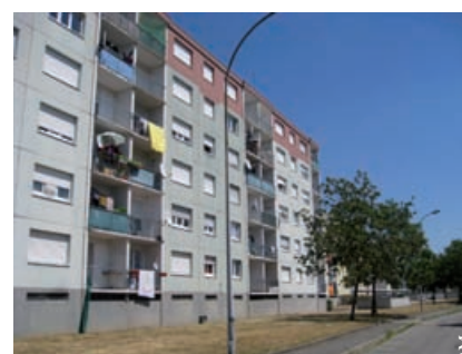
La Thur et Markstein– logements sociaux
