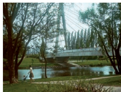
Montagne-Verte – Passerelle de l'Illhof
