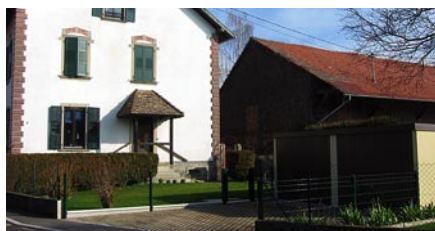
Exemple de création de places de stationnement supplémentaires en rénovation urbaine
