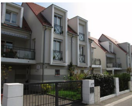
Les Villas de la Treille à Illkirch-Graffenstaden
