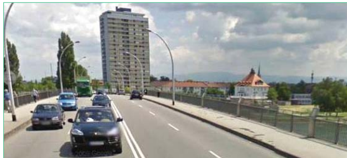
La tour d'habitation de Kehl, un immeuble de grande hauteur positionné avec justesse : sur un point symbolique (porte de l'Allemagne), à l'échelle d'un élément naturel majeur (le Rhin) et à proximité d'un transport public majeur (gare ferroviaire de Kehl)
