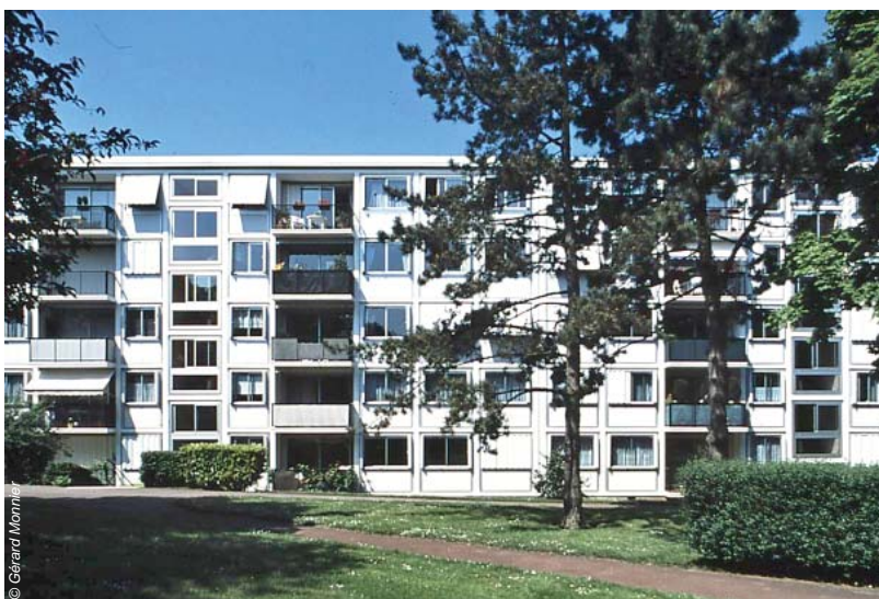
Marly, les Grandes Terres, 1955-1958, Lodset Honegger arch.
