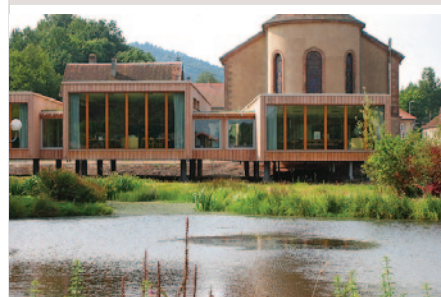
UNE ARCHITECTURE CONTEMPORAINE QUI JOUE DE LA PRÉSENCE DE L'EAU ET LA VALORISE.
