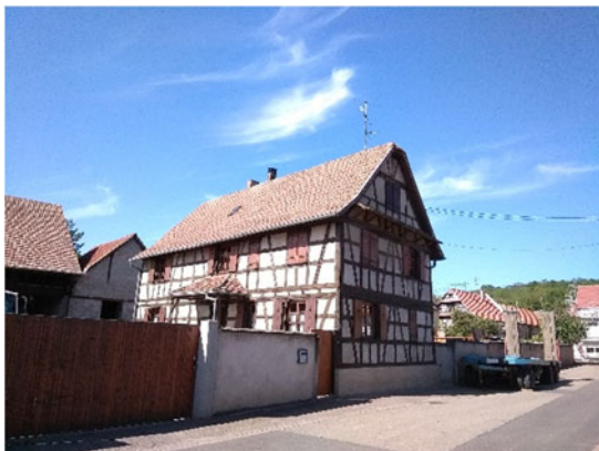
12 rue de la Marne
