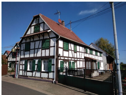
19 rue de la Marne
