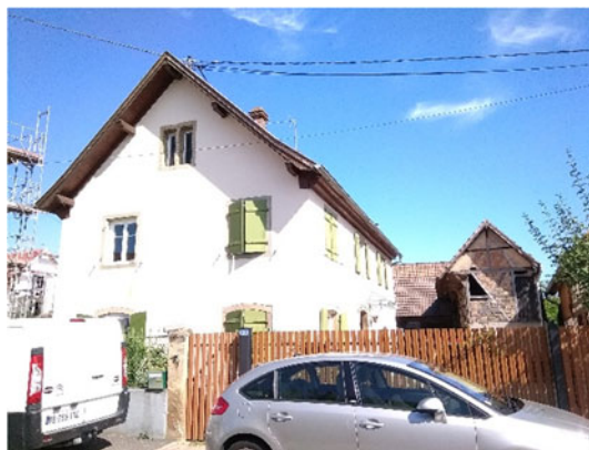
9 rue de la Marne
