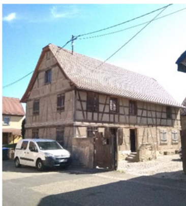
4 rue de la Marne
