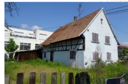
1 rue des Soeurs
