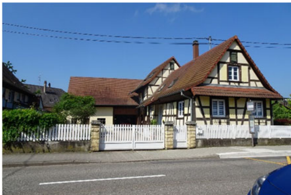
7 rue du Général Leclerc
