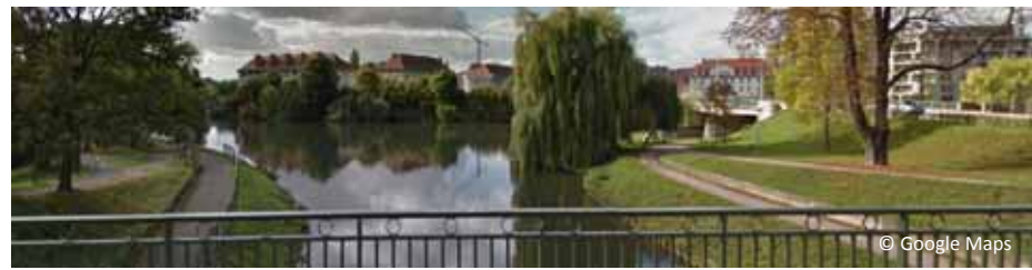
Confluence entre le cours de l'Ill, le Canal du Rhône au Rhin et le Rhin et le Rhin Tortu.
