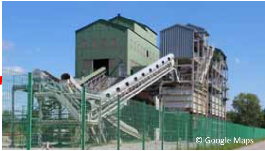
Exploitation de la gravière au bord de l'étang du Gerig
