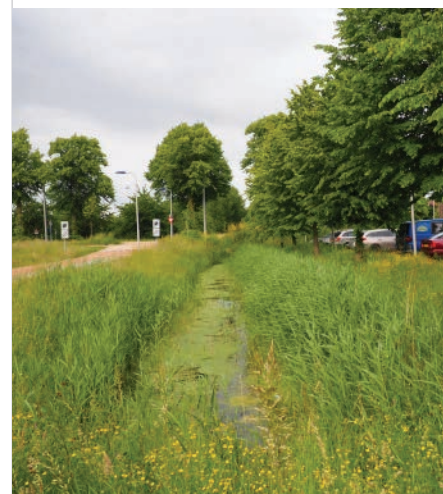
UNE NOUE DE RÉCOLTE DES EAUX PLUVIALES QUI PARTICIPE À STRUCTURER LE QUARTIER D'EVA-LANXMEER
